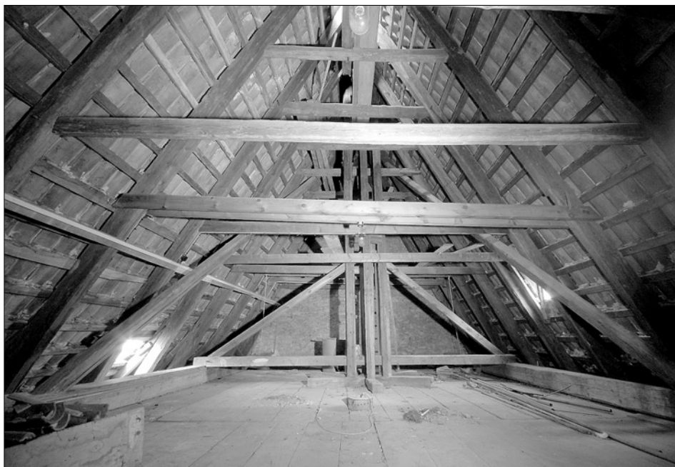
Obr. 6: Praha - Podolí, kostel sv. Michaela archanděla, celkový pohled do prostoru krovu lodi od západu. V centru je patrná štenýřová konstrukce sanktusníku (foto V. Tutr, 2006).
