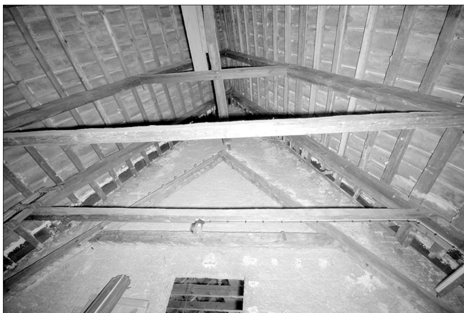
Obr. 13: Praha - Podolí, kostel sv. Michaela archanděla, pohled na západní, požární štít lodi, mezi starým a novým krovem. Na obrázku je dobře patrná poslední vazba krovu nad novější částí lodi, která je konstrukcí štítu oddělena vazeb předchozích (foto V. Tutr, 2006).
