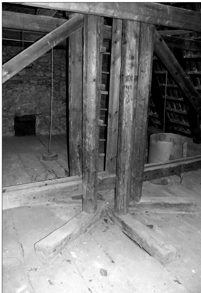
Obr. 8: Praha - Podolí, kostel sv. Michaela archanděla, detail paty sanktusníku. Štenýřová konstrukce je uložena prostřednictvím šestipaprscitého roštu přímo na záklop stropu lodi. Na středních štenýřích je patrné ryté vnoření (foto J. Veselý, 2006).
