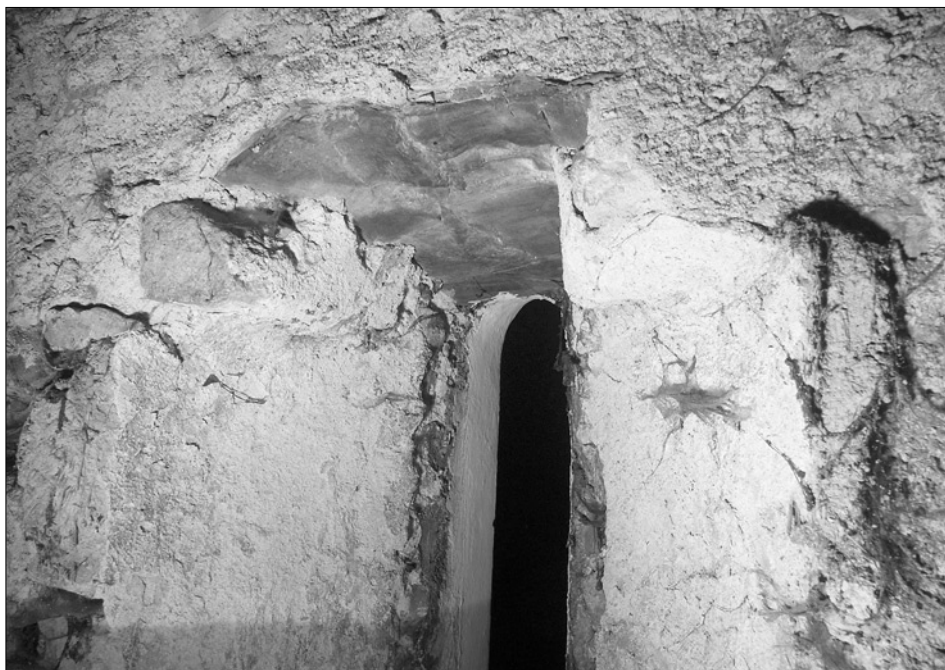
Obr. 16: Praha - Podolí, kostel sv. Michaela archanděla, detail horní části niky dolního okna ve východním štítu presbytáře. Nika má stupňovitý kamenný překlad. Špalety niky jsou pokryty hrubou omítkou s vápennými nátěry. Po obou stranách niky jsou na vnitřním lici štítu hroudy hliněné mazaniny s otisky svislých prvků. Omítka špalet přechází i na boční plochy hrud (foto J. Veselý, 2006).
