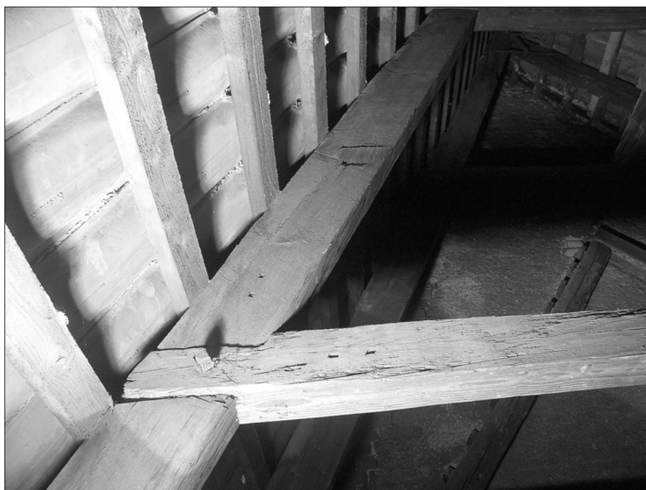
Obr. 9: Praha - Podolí, kostel sv. Michaela archanděla, detail plátového spojení spodního hambalku druhé vazby gotického krovu lodi. Na krokvi i hambalku jsou patrné dvojice „obdělňáček“ značení. V horní části obrázku je na přivráceném svislém lici krokve patrný trojúhelníček po rozlomení trámu při púlení ruční pilou (foto J. Veselý, 2006).
